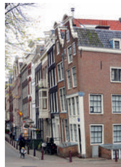
La Maison Penchée
